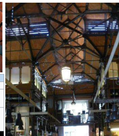
VENTILACIÓN POR MEDIO DE LOS TECHOS DEL MERCADO SAN MIGUEL
