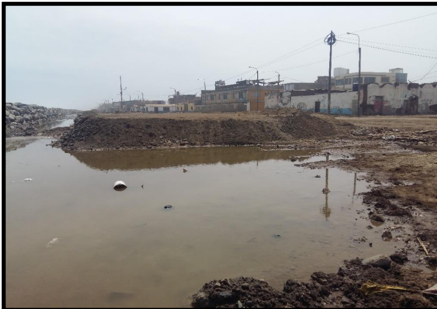
Imagen 7 - Equipamientos afectados (Buenos Aires Norte)
