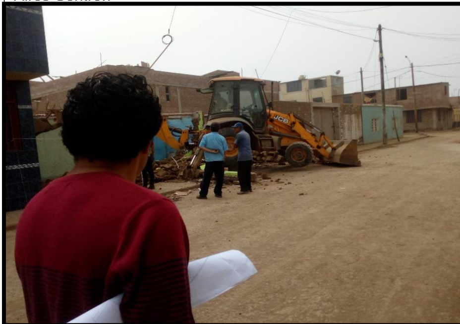
Imagen 6- Reparación de viviendas colapsadas (Buenos Aires Centro.)
