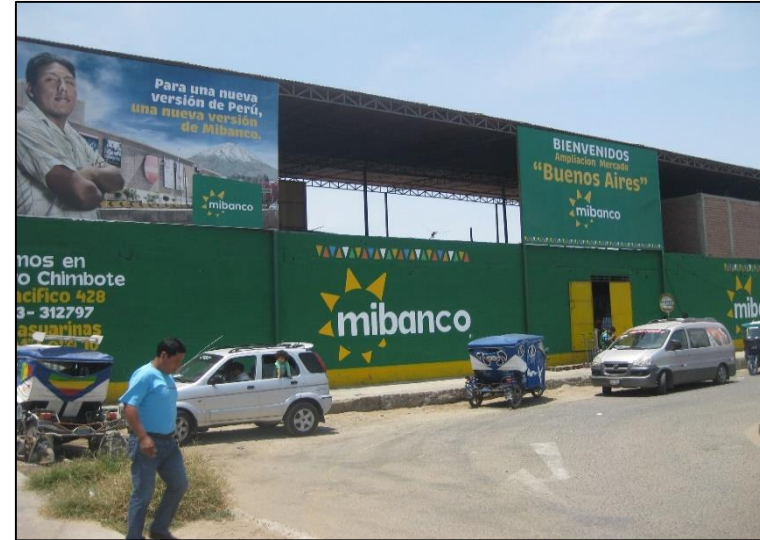
Figura 77. Fachada Principal Mercado. Elaboración propia.
