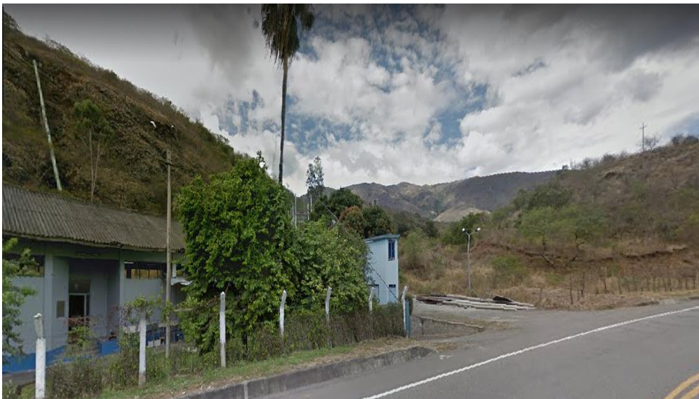
Figura 8: central hidroeléctrica Pucara. Fuente: propia.
