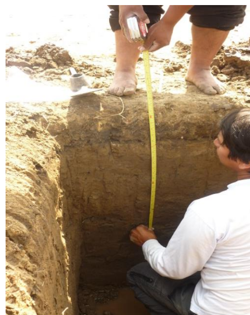
EXAVANDO CALICATA Y VERIFICANDO EXCAVACION AL 1.50MT
