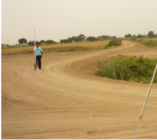
VISUALIZANDO LEVANTAMIENTO ALTIMETRICO Y PLANIMETRICO
