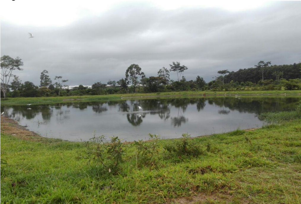
Laguna de oxidación secundaria PTAR Soritor
