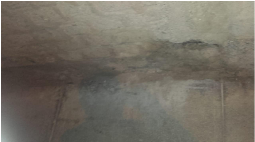
FIGURA 35 absorción de las unidades de albañilería en las viviendas
