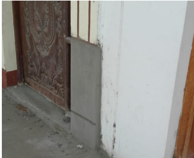
FIGURA 36 reparación de columna
