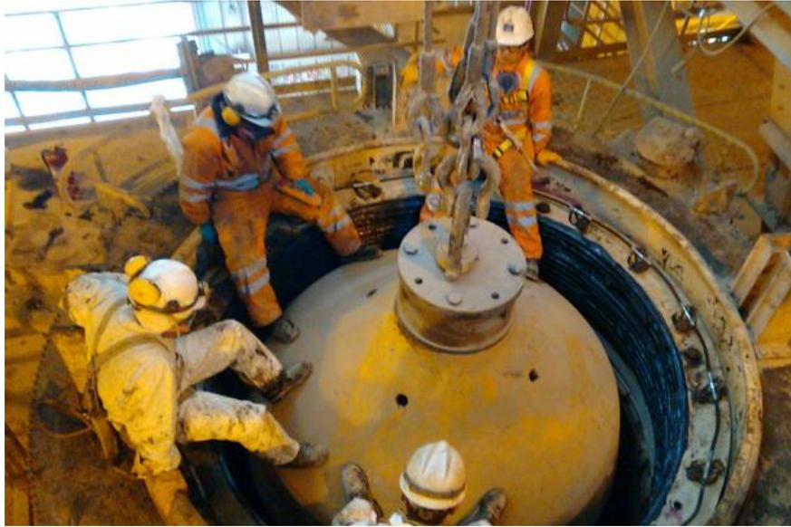
(Gráfico 6: Instalación Liners de desgaste de las chancadoras Cónicas)
