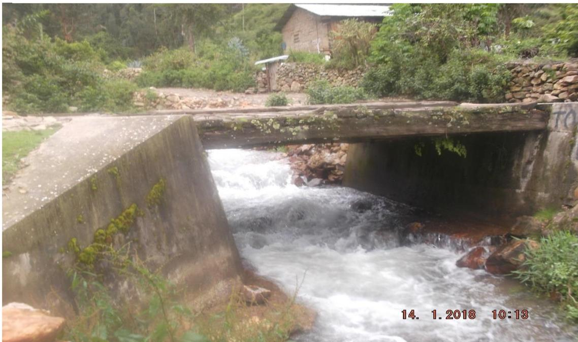
Figura 11: Se observa el puente que tiene poca distancia de parco y la carretera de acceso al barrio de shirapata
