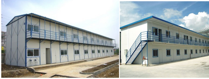
Şekil 2.4 Modül Prefabrikasyon Konut – Geleneksel Tasarım (Gözde Konteyner, 2018)
