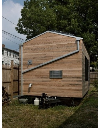
Şekil 3.12 Walden Studios – Dimka Wintzel Tiny House – Yağmur Suyu Toplama (Archdaily, 2019)
