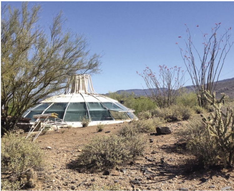
Paolo Soleri, Dome house
