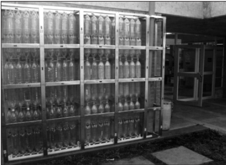
Foto 3. Construcción e instalación del muro cisterna
