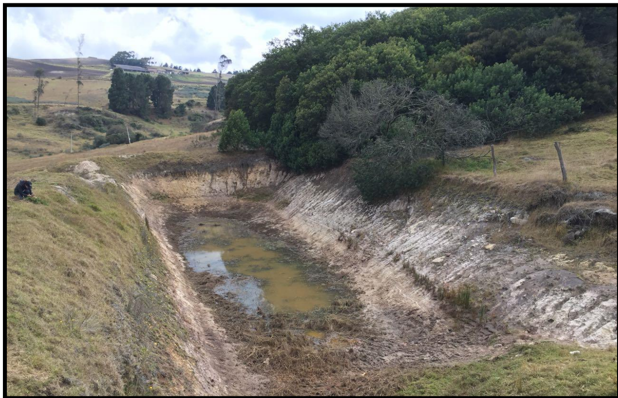
Anexo 6 Antigua bocamina con colapso de la zona superior
