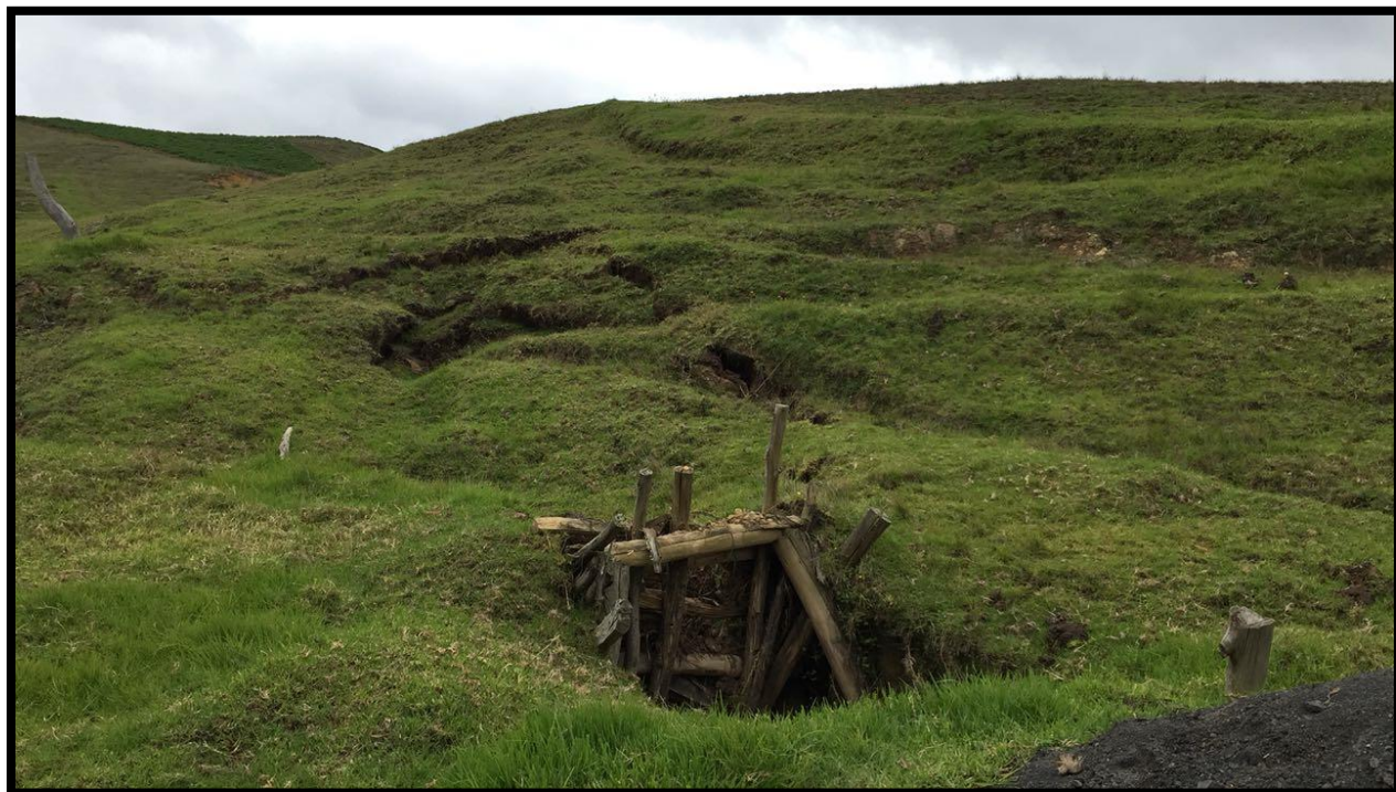
Anexo 6 Antigua bocamina con colapso de la zona superior
