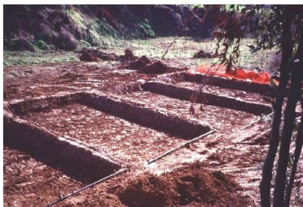
Figura 13: Conformación espacial de las celdas en un humedal construido. Tomado textualmente de: García & Corzo. (2008)
