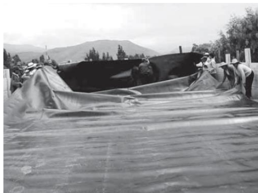
Figura 15: Instalación de geomembrana en un humedal artificial. Tomado textualmente de: Delgadillo et al. (2010).
