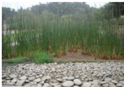
Figura 25: franja de material granular en la zona de entrada de un humedal subsuperficial. Tomado de: Von Münch (2009).
