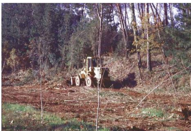
Figura 12: Limpieza de la plataforma de trabajo en la construcción de un humedal. Tomado textualmente de: García & Corzo (2008).
