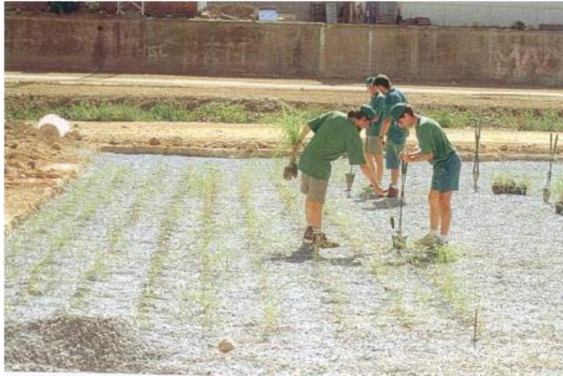
Figura 18: Operaciones de plantación de la vegetación en un sistema de humedal. Tomado textualmente de: García & Corzo (2008).
