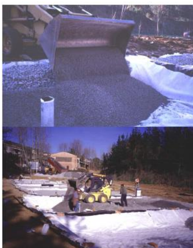
Figura 16: Relleno del lecho con material granular en sistema de humedal. Tomado textualmente de: García & Corzo (2008).
