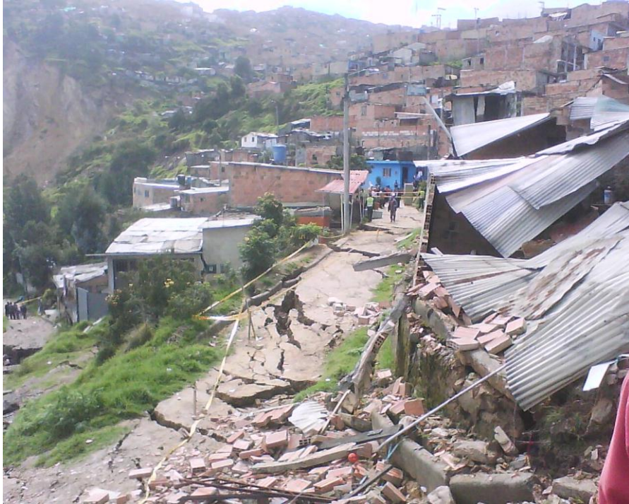
Fotografía 8: Deslizamientos en el área urbana del municipio de Soacha
