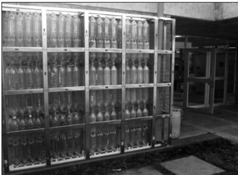
Foto 3. Construcción e instalación del muro cisterna
