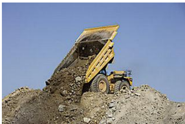
Figura 4. Descargue de material estéril
