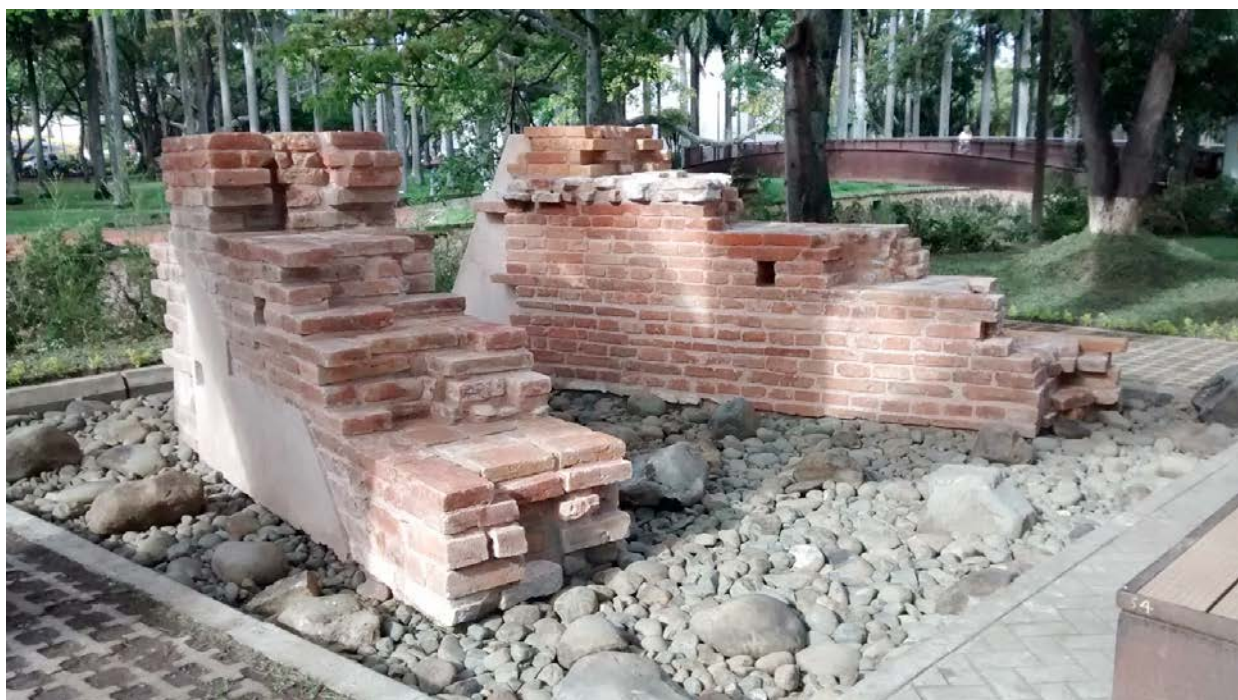
Imagen 3. Muros del Puente Ortiz
