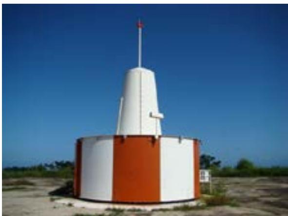
Imagen 13. DME (Distance Measuring Equipment) o sistema electrónico de distancia (Telemetría)
