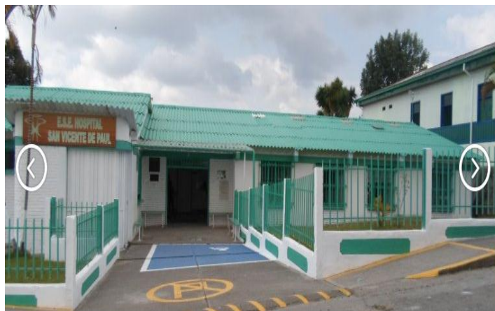
Figura 1. Fachada del Hospital carrera quinta.
