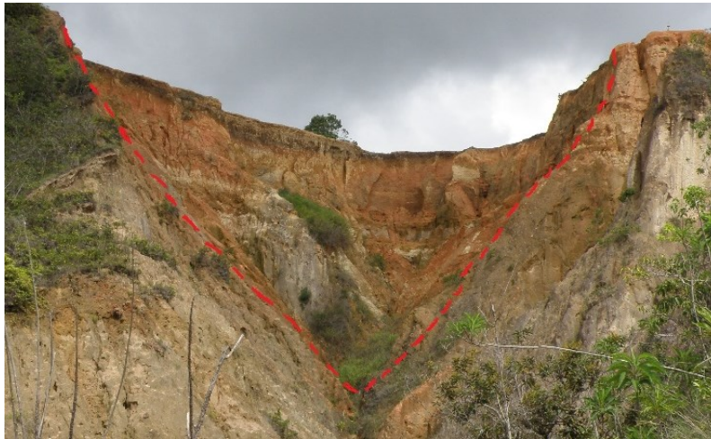
Fotografía 25: Forma de “V” de la cárcava observada en campo.
