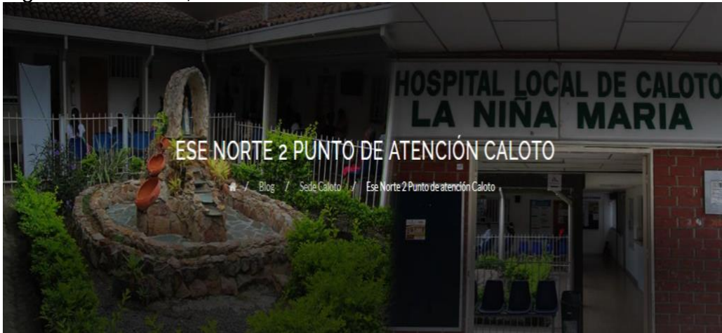
Figura 1. Fachada, institución ESE NORTE 2 CALOTO CAUCA
