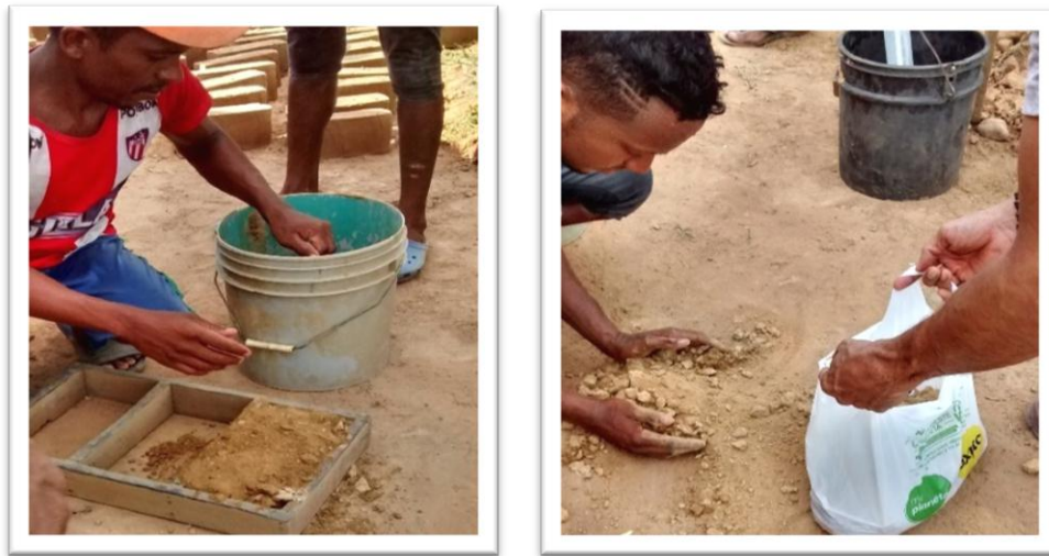
Imagen 10. Cantidad de arcilla de un ladrillo
