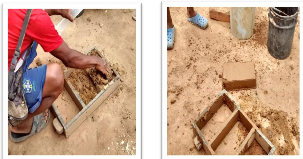
Imagen 11: Cantidad aproximada de arcilla de un ladrillo
