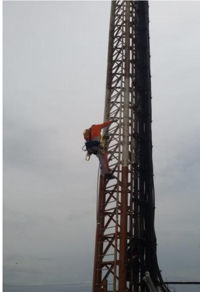
Ilustración 14. Se Mantiene siempre tres puntos de apoyo (2 pies y a mano mientras transita cambia un brazo de la eslinga de punto de anclaje o dos manos y un pie mientras realiza el desplazamiento vertical).
