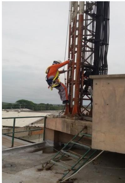
Ilustración 12. Ascenso ocasional y rutinario, con inspección visual del área, se retiran los obstáculos que pongan en riesgo la labor.
