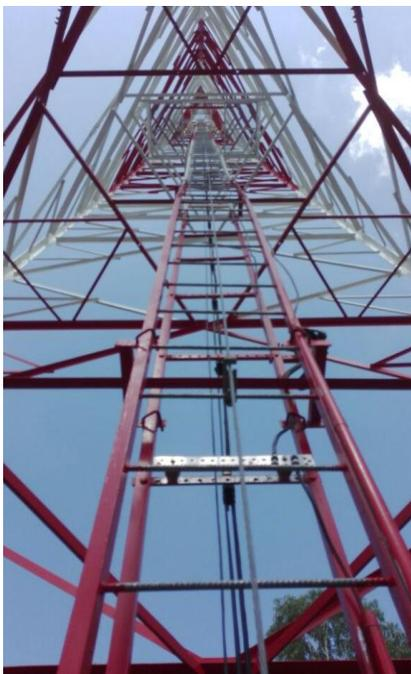
Ilustración 4. Línea de vida fija, son instaladas por el fabricante son de cable de acero, de ella se conecta el arrastrador o freno.
