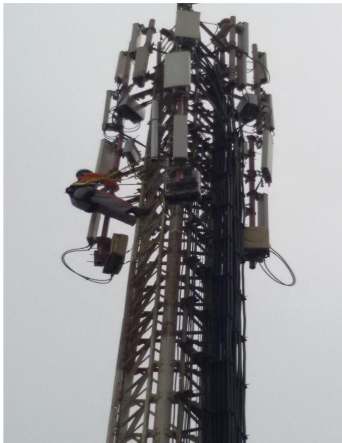
Ilustración 16. Según el trabajo a realizar, para darle una mayor seguridad a la ejecución de la labor, conecta la banda de anclaje o Tie Off a la estructura de trabajo y conéctelo a su argolla pectoral por medio del mosquetón.
