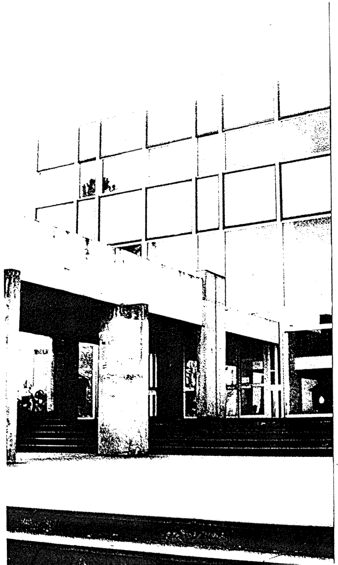
Façade Est de la bibliothèque. Ancienne entrée.
