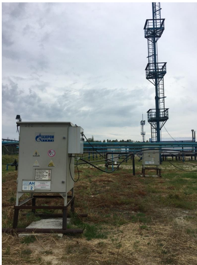
Рисунок 13 – Установка дозирования химического реагента
