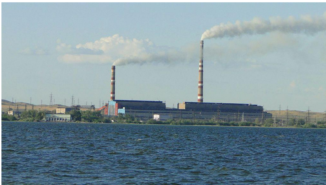
Рисунок 3 – ТОО «Главная распределительная энергостанция»
