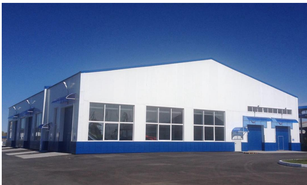
Рис. 1 – Вид стояночного бокса
