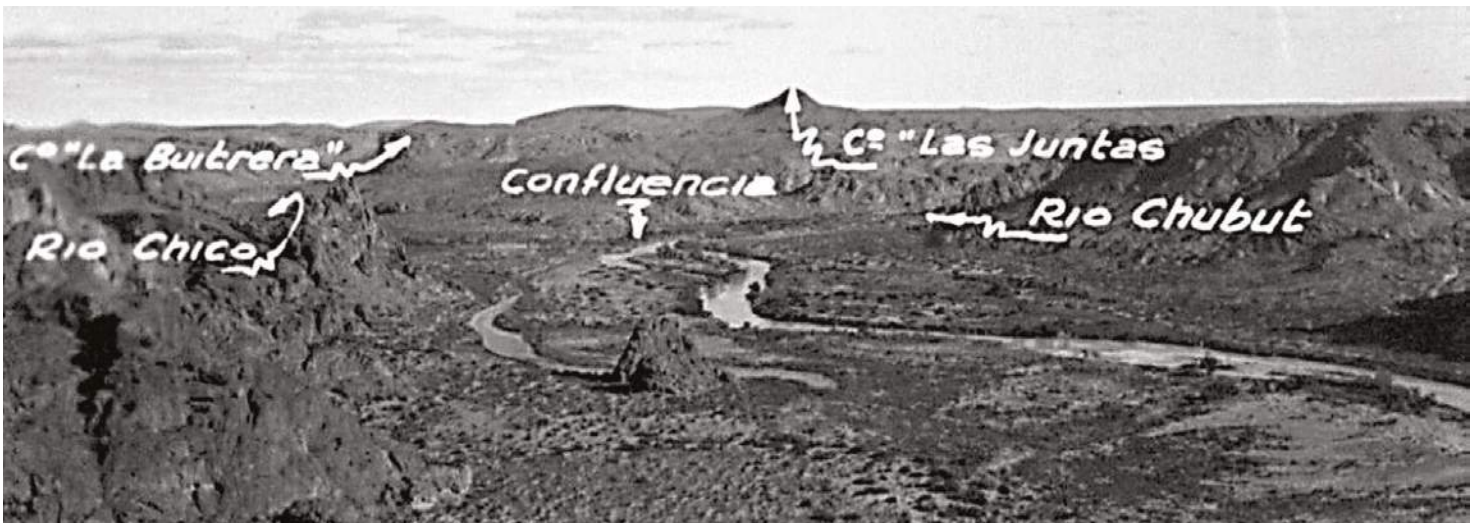
Figura 2. Confluencia del Río Chubut y Río Chico antes de la construcción del Dique F. Ameghino (década de 1940). Vista desde el borde sur del valle mirando hacia aguas arriba. A la derecha se observa el valle del río Chubut, mientras que el Río Chico proviene desde la izquierda de la foto. Pronsato 1950.
