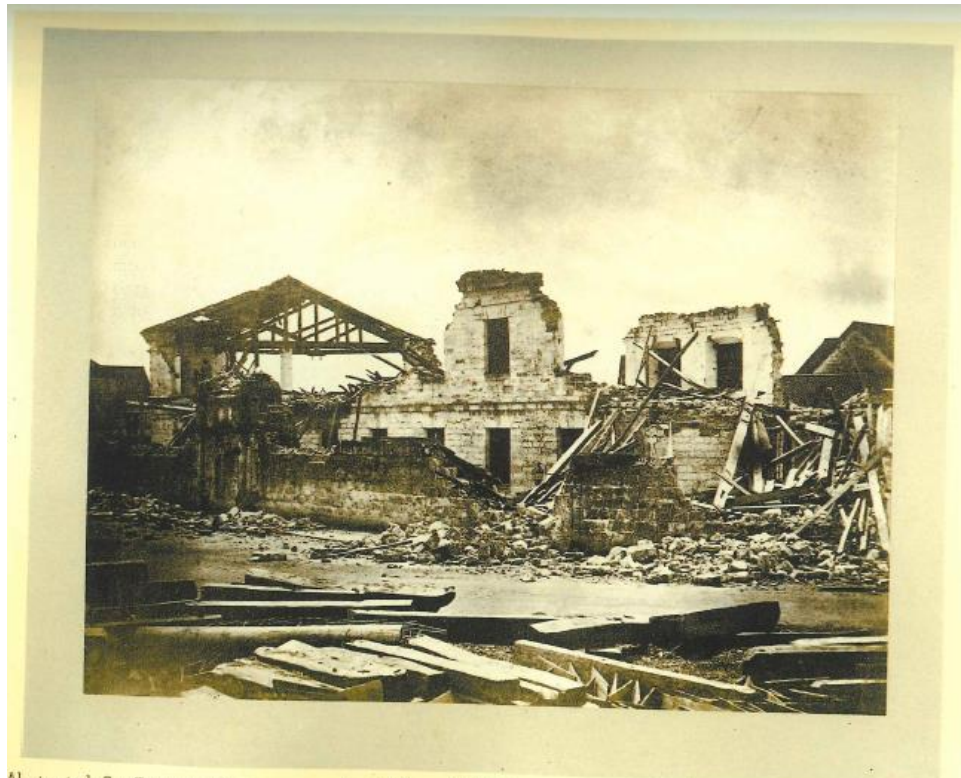
Alcaicería de San Fernando. Almacenes generales de tabaco del Gobierno, en Manila, después del terremoto del 3 de Junio de 1863.
