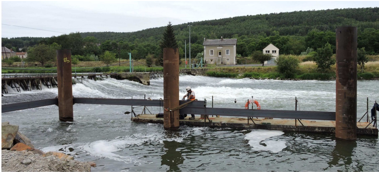
Figure 21 : Vue du barrage à aiguilles d'Ham sur Meuse (source : http://www.bameo.fr )
