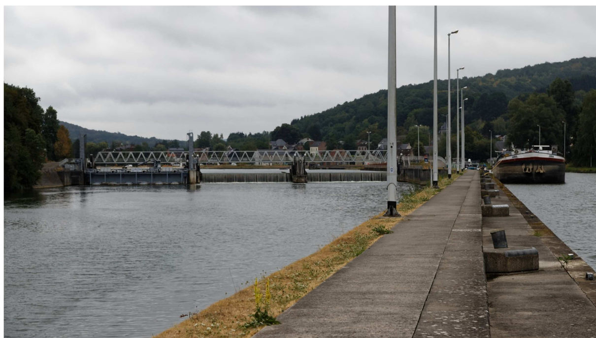
Figure 25 : Vue du barrage et de l'entrée de l'écluse d'Hastière (50°12'13.2"N 4°49'09.3"E)
