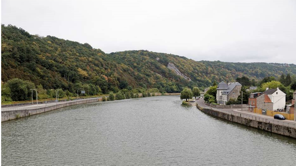
Figure 22 : Vues générales de la Meuse à Hastière-Waulsort depuis l'amont (haut) et l'aval (bas) du pont d'Hastière (50°12'56.8"N 4°49'37.0"E)
