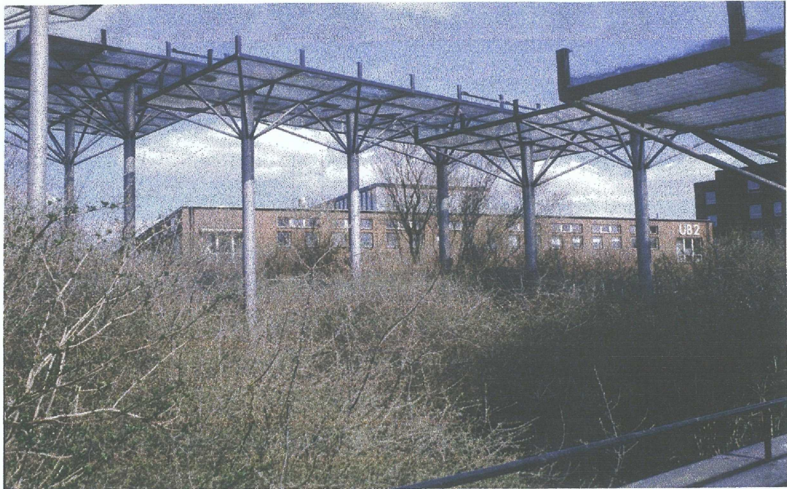
Vue de la façade avant de l'U.B.2.
