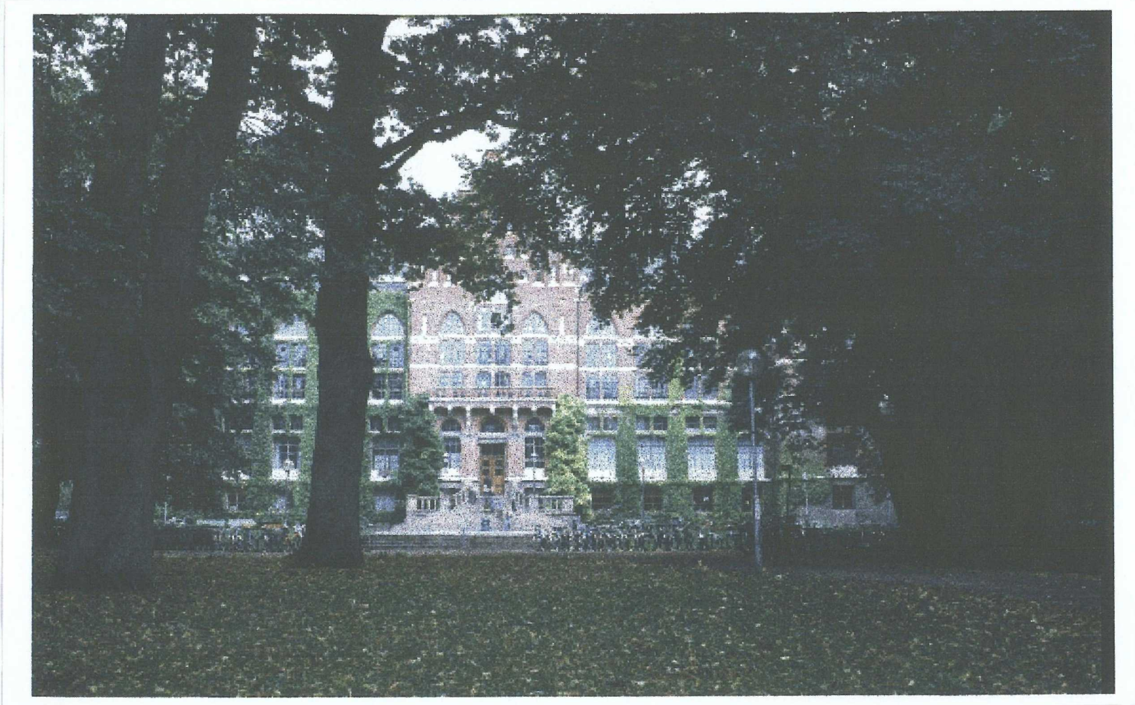
Vue de la façade avant de l'U.B.1.
