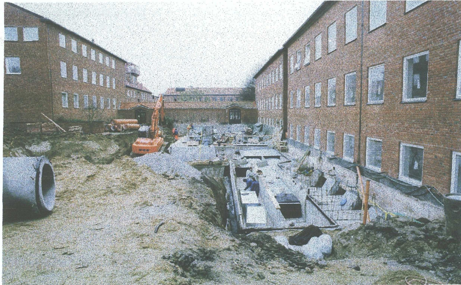
Vue de travaux d'agrandissement du département de physique (faculté de sciences).
