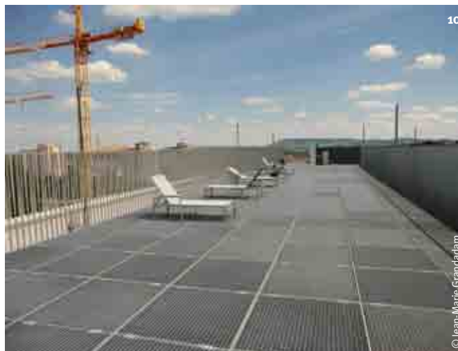
La terrasse sur le toit.
