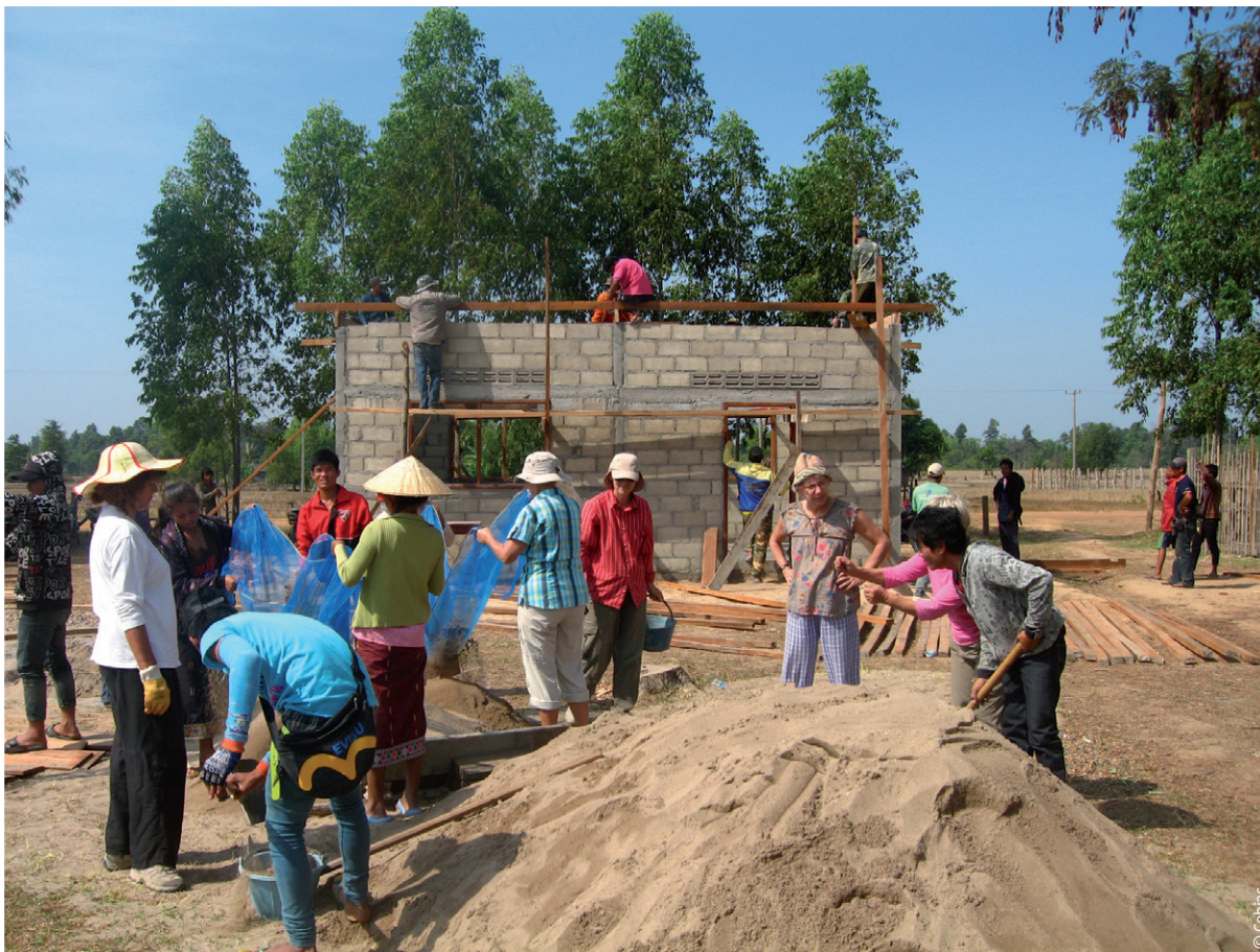
Les volontaires poursuivent les travaux sur le chantier de la bibliothèque / Volunteers keep on working on the construction site of the library.
