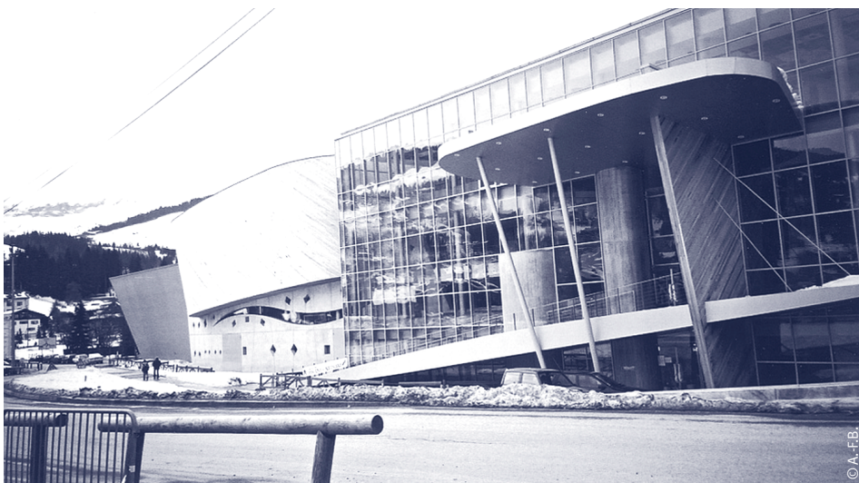
Le parvis est abrité par un vaste auvent, prolongement d'une longue esplanade.
