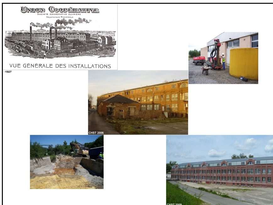
Fig. 1 : Illustration du processus d'assainissement d'un site d'activité économique désaffecté – Site dit « Société Générale Coopérative » à Soumagne (Réf. DGO4 – LG199). En haut à gauche : vue générale des installations vers 1927 (pleine activité) ; au centre : vue des installations à l'abandon en 2006 ; en haut à droite : illustration d'une campagne de prélèvement de sol ; en bas à gauche : illustration d'un assainissement par excavation ; en bas à droite : situation en 2009, situation après assainissement et rénovation de l'enveloppe extérieure.
