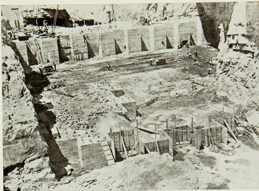
Mayo de 1945.—Detalle del hormigonado de cimientos de la presa
