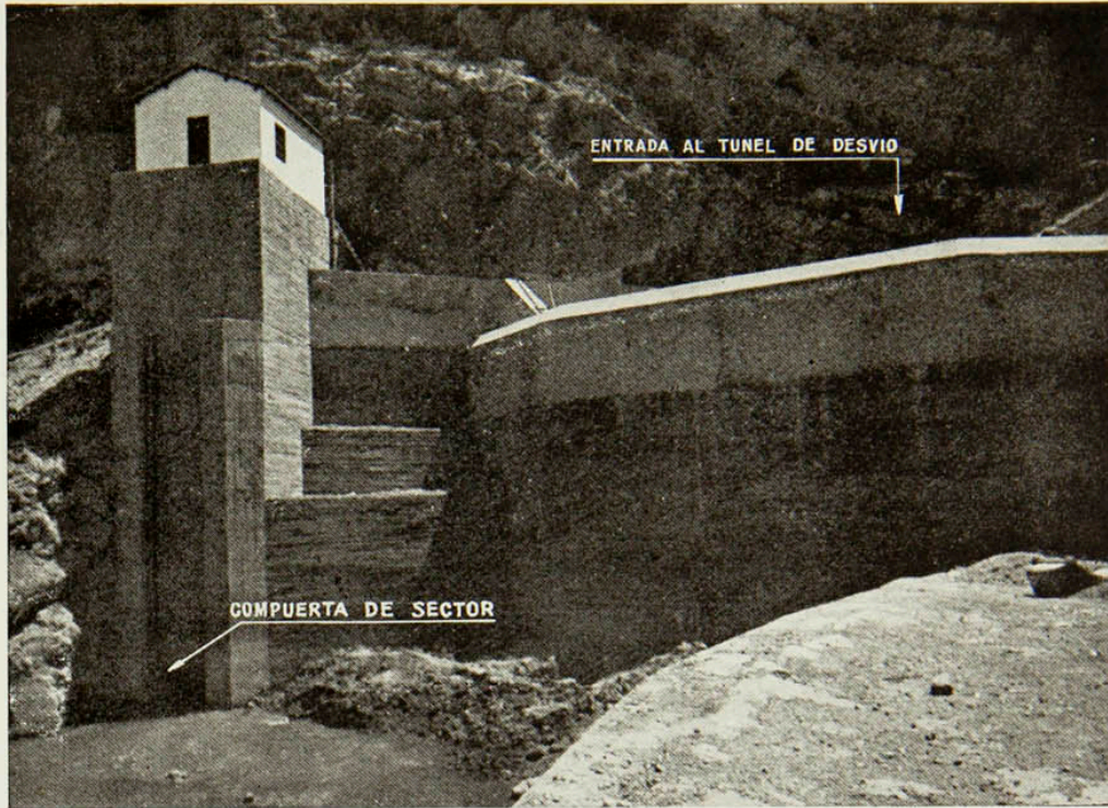
Julio de 1945.—Muro-atagüa y compuerta de sector para la producción de embalses parciales por medio de la atagüa definitiva sistema «Peña»
