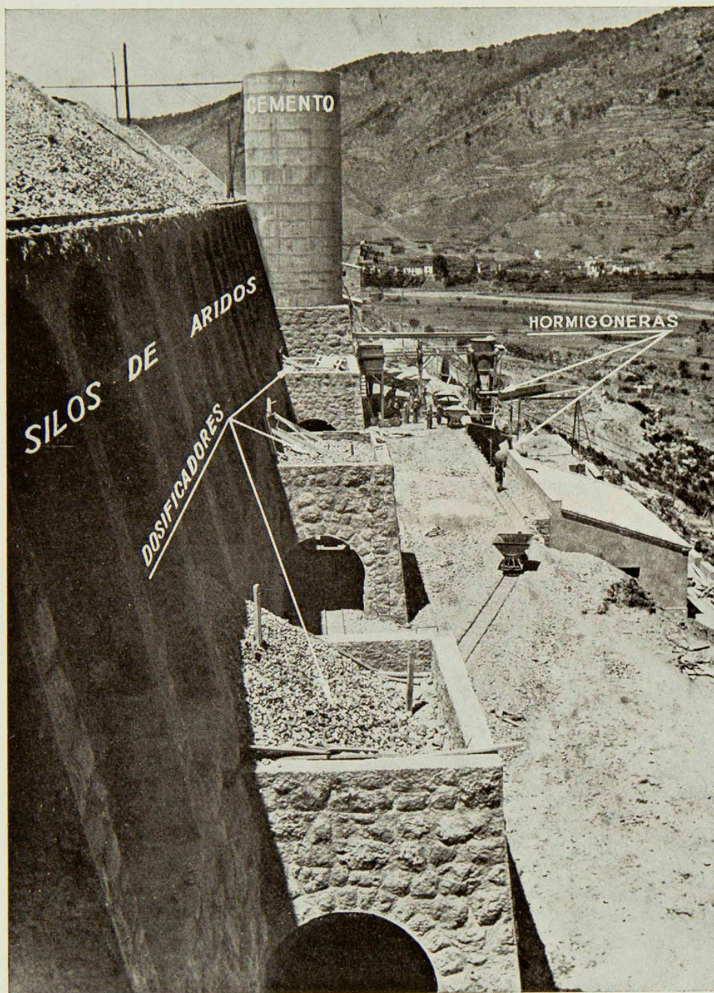
Mayo de 1945.—Plataforma de suministro y dosificación de áridos
