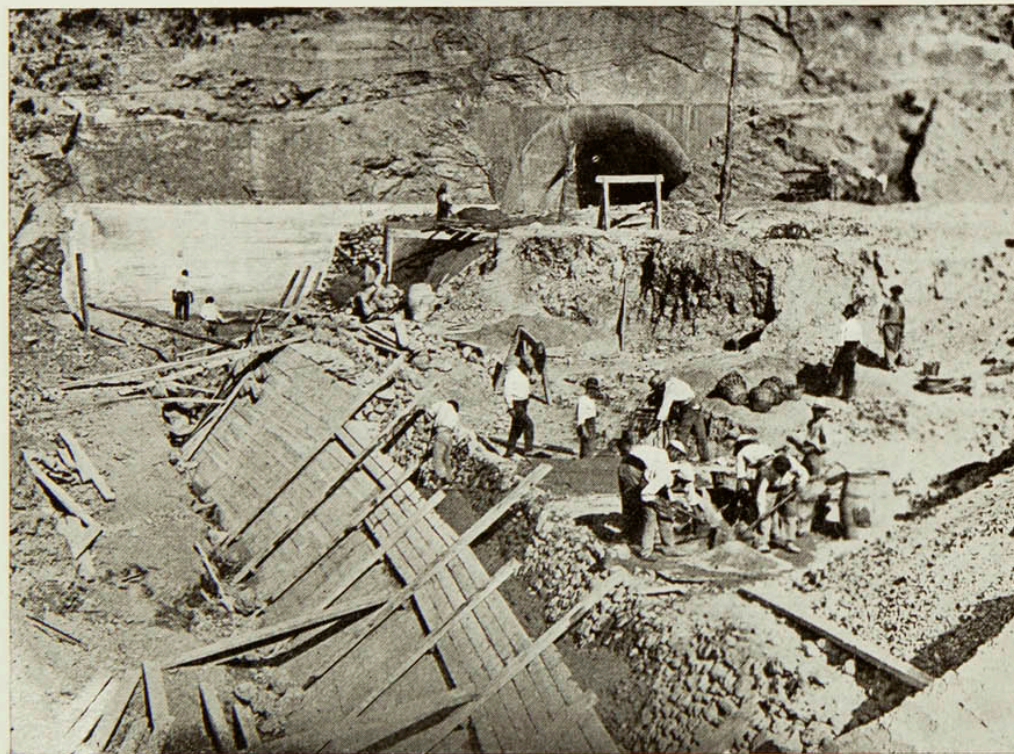
Julio de 1935.—Construcción del desvío provisional de las aguas superficiales
