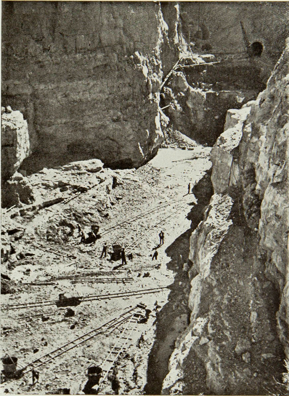
Noviembre de 1943.—Excavación de cimientos para la presa, hacia aguas abajo
