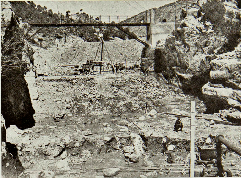
Septiembre de 1935.—Ejecución de la pantalla de pilotes Rodio y excavación de cimientos de la ataguía
