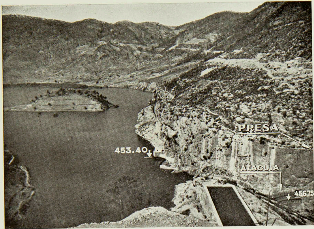
Julio de 1945.—Embalse provisional y obras
