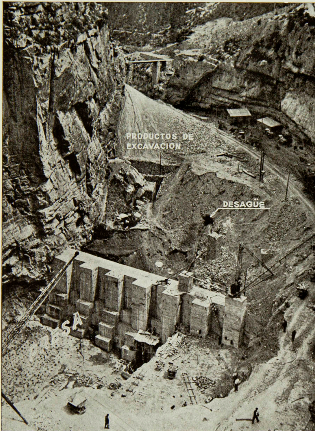
Junio de 1945.—Obras de ejecución de la presa
