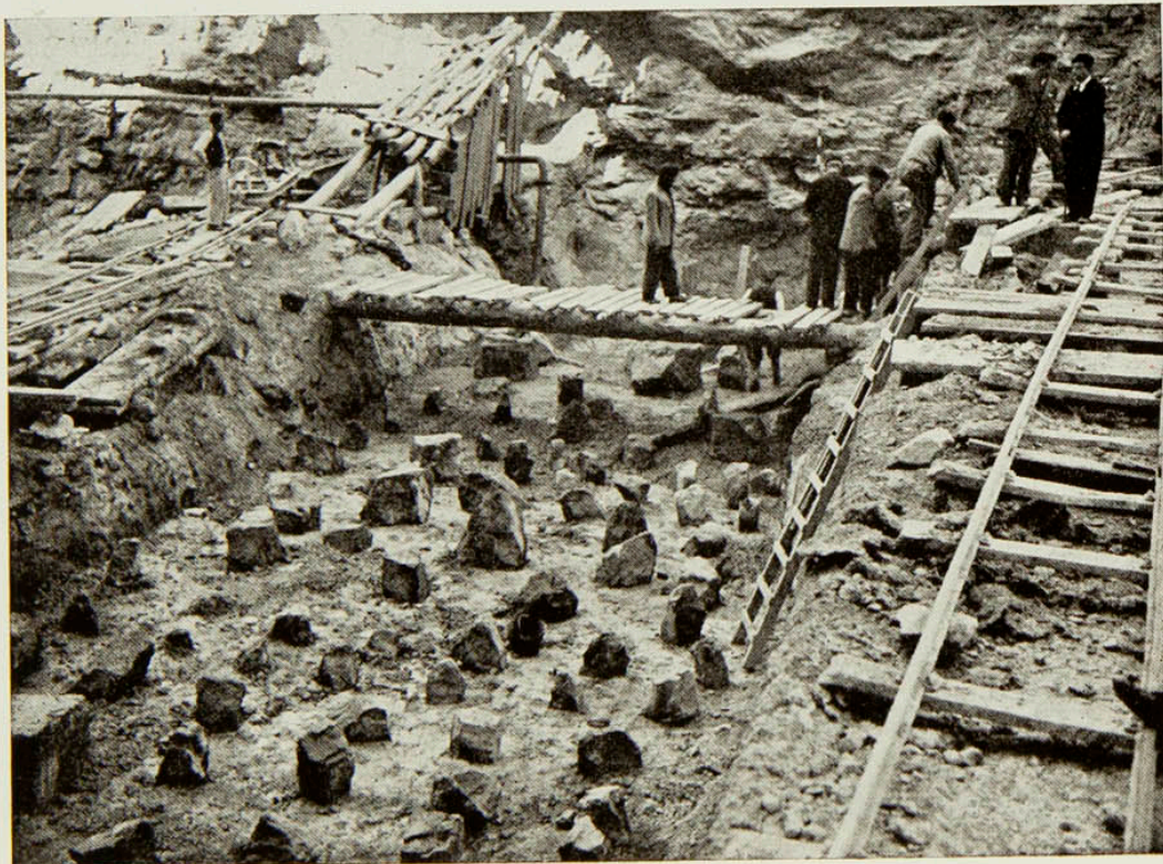
Marzo de 1945.—Hormigonado del rastrillo de aguas arriba de la presa
