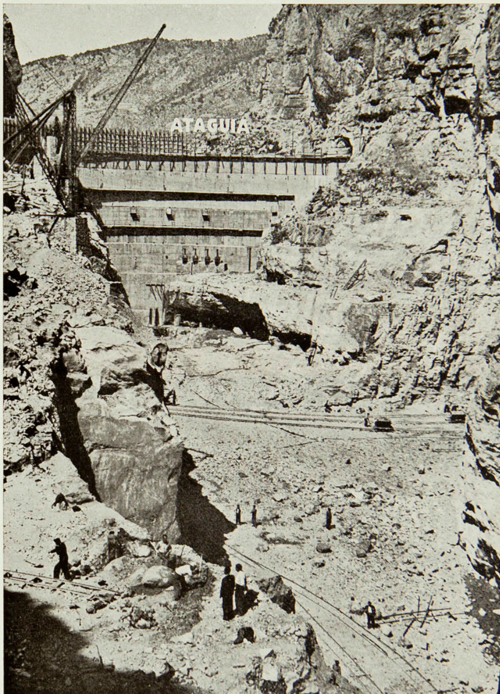
Abril de 1944.—Excavación para cimientos de la presa y hormigonado del sexto anillo de la ataguja definitiva
