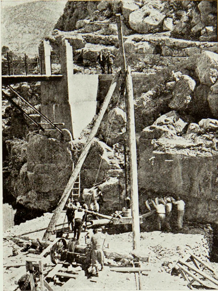
← Julio de 1935.—Ejecución de la pantalla de pilotes para desvío provisional de las aguas subálveas
