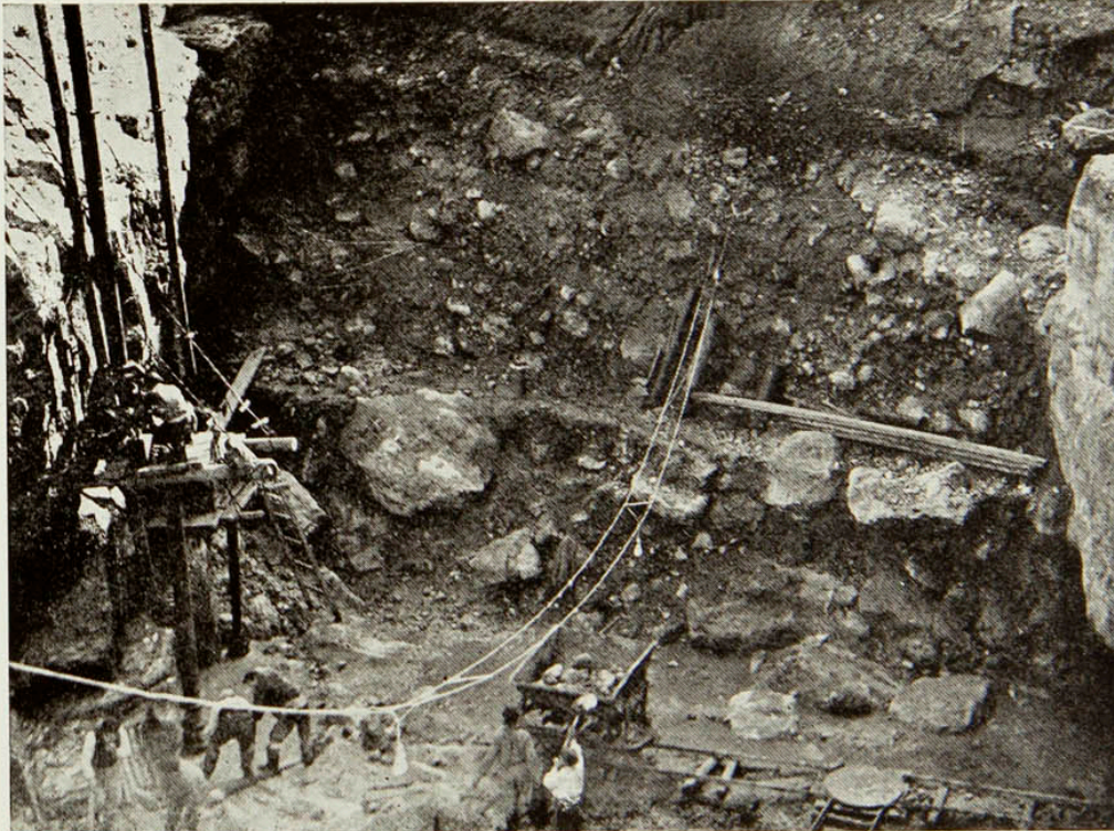
Enero de 1936.—Excavación de cimientos para la ataguía definitiva
