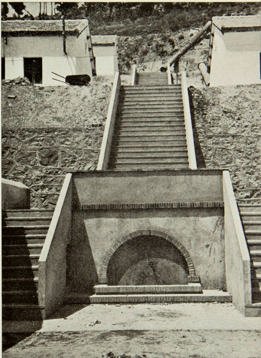
Julio de 1945.—Escalinata de acceso a las viviendas familiares para obreros
