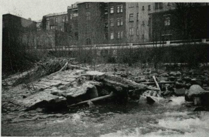
Bild 1: Zerstörtes Textima-Wehr in der Zwickauer Mulde, Aue/Erzgebirge
