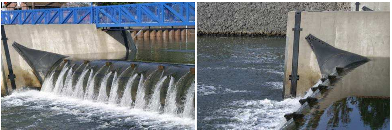
Bild 1: Schlauchwehr Bannetze an der Aller unmittelbar nach der Fertigstellung im Oktober 2009
