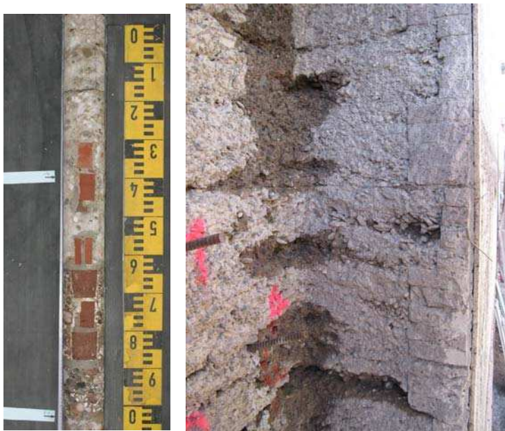
Bild 1: Injizierter Bohrkern (links), Verbund Vorsatzschale-Kernbeton (rechts)
