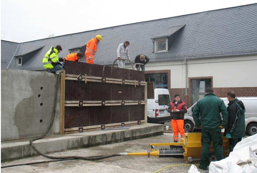
Bild 1: Einbau des schnell erhärtenden, selbstverdichtenden Instandsetzungsmörtels
