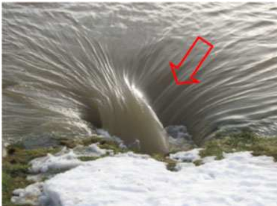
Abbildung 2: links: verstärkte Strudelbildung wasserseitig; rechts: Dammbbruch
