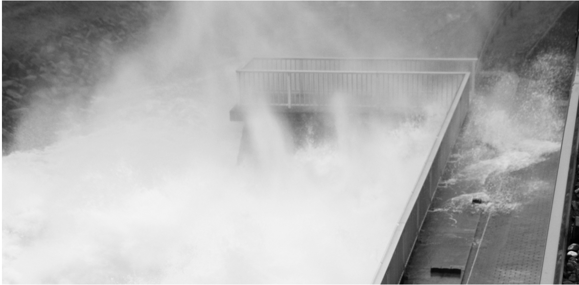
Abbildung 6: Übertretende Schwallwellen bei 70 %-iger Öffnung des GA 3
