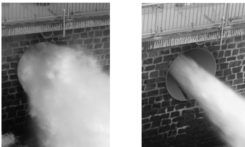
Abbildung 3: Vergleich des Wurfstrahls bei 20 % (links) und 80 % (rechts) Öffnungsgrad am Beispiel der mittleren Grundablass (GA 2)
