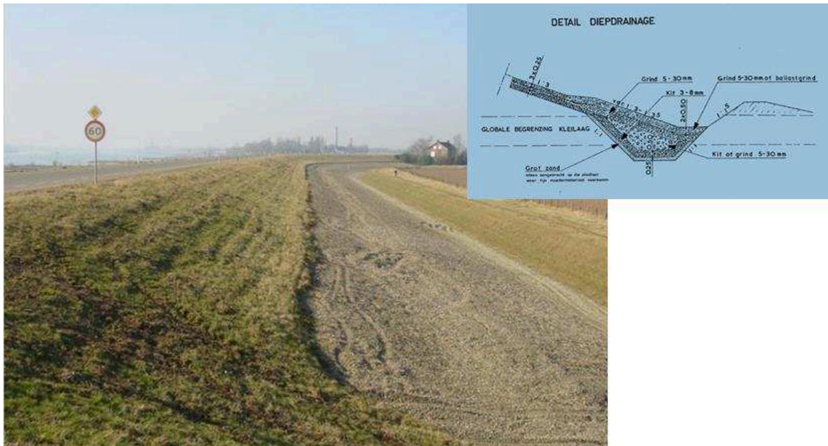
Abbildung 2: Kiesdrainage am Rhein bei Spijk (NL)
