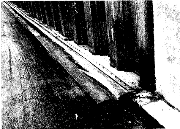
Bild 5c: Anschluß an Spundwand
