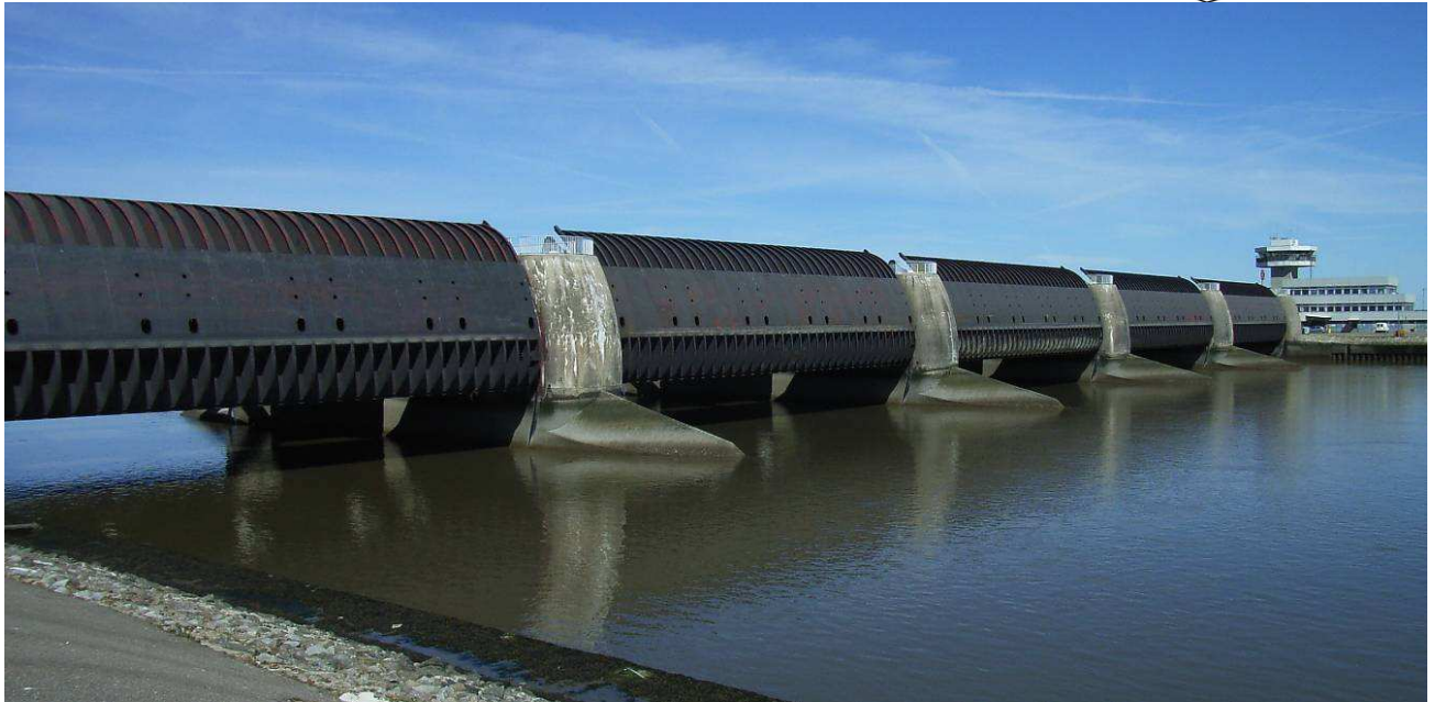
Bild 1: Sielbauwerk des Eidersperrwerks (von der Binnenseite)
