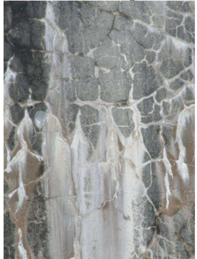
Bilder 2 und 3: Netzrisse am Korbbogen des Pfeilers 1 (Binnenseite) oberhalb NN + 2,00 m im Bereich des PZ-Betons. links: Übersicht, rechts: Detail
