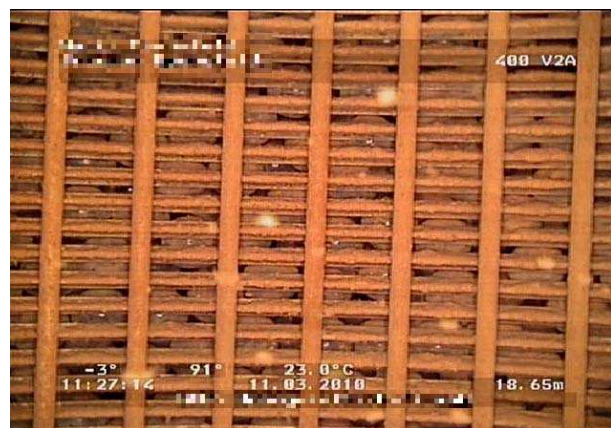
Bild 2: Anlagerung von Eisenhydroxiden an Glaskugeln in einem Wickeldrahtfilterbrunnen. Foto: Fa. Ochs, Nürnberg
