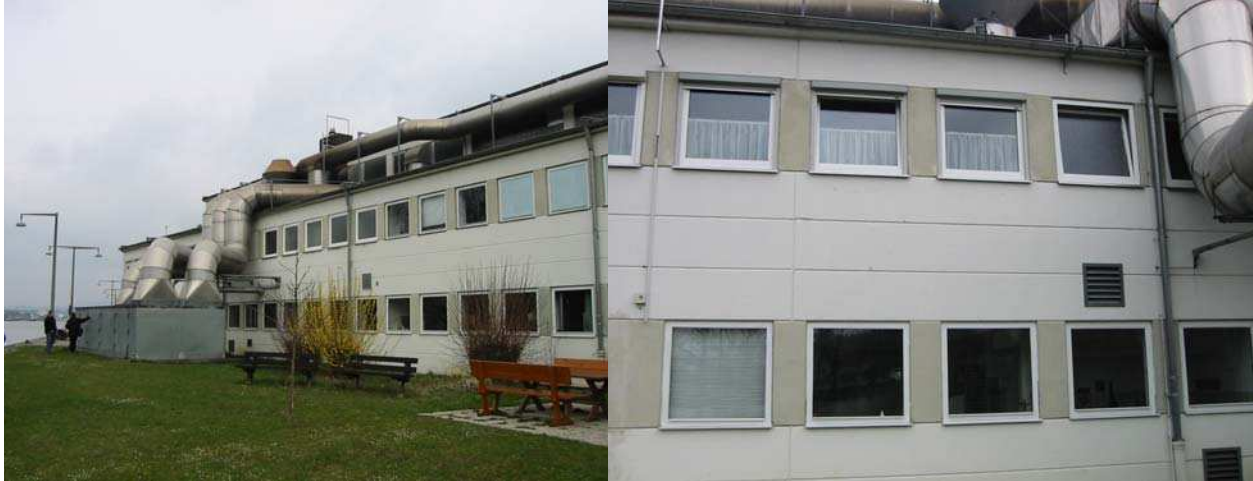
Abbildung 10: Ansichten Bauhofgebäude von Süden/ Donauufer. Die Lüftungsanlage versorgt die Werkhalle mit Frischluft. Rechts: Fenster wurden bereits teilweise ausgetauscht (oberes Fensterband mit neueren Kunststofffenstern, unten alte Fenster mit Metallrahmen).
