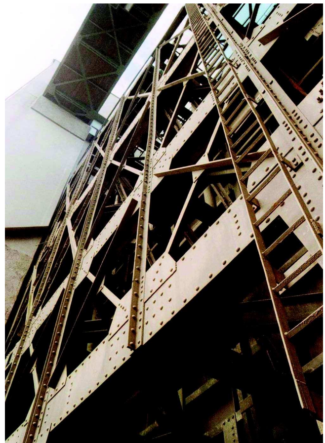
Bild 2.3: Schleuse Feudenheim, Untertor, linke Kammer
