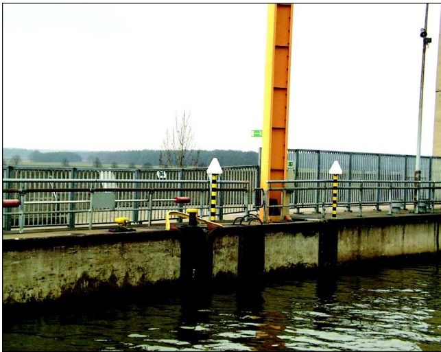
Bild 7.5: Antennen auf Messpfeiler UH und Block 1
