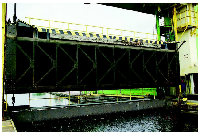
Bild 2.11: Trogtor - hier das oberwasserseitige Tor (Ansicht vom Trog)
