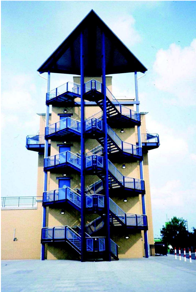
Bild 2.8: Ansicht des Schleusenbetriebsgebäudes mit der Treppenanlage zur Aussichtsplattform
