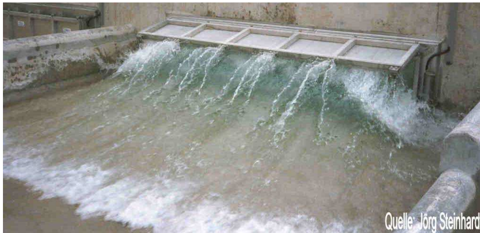
Abbildung 1 Spülwelle in einem Regenüberlaufbecken (Foto: Steinhardt Wassertechnik).
