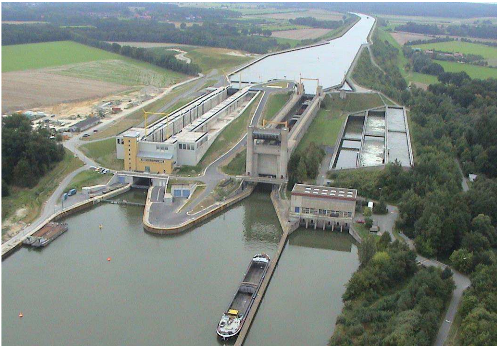
Bild 1: Neue Schleuse Uelzen II (links) und alte Schleuse Uelzen I (rechts); Foto: NBA Hannover
