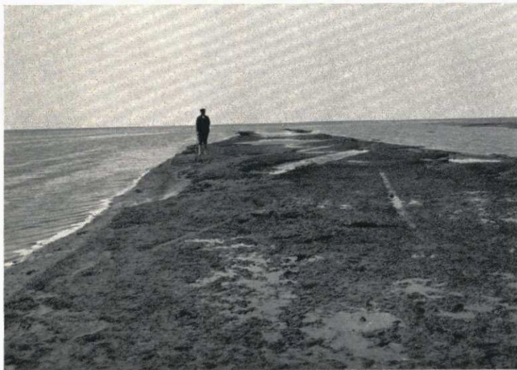
Abb. 22. Ehemalige Landoberfläche als Untergrund des vernichteten Deiches.
